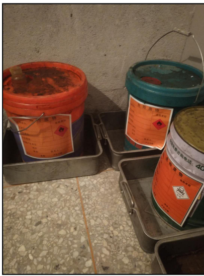
废油桶及防渗漏托盘
